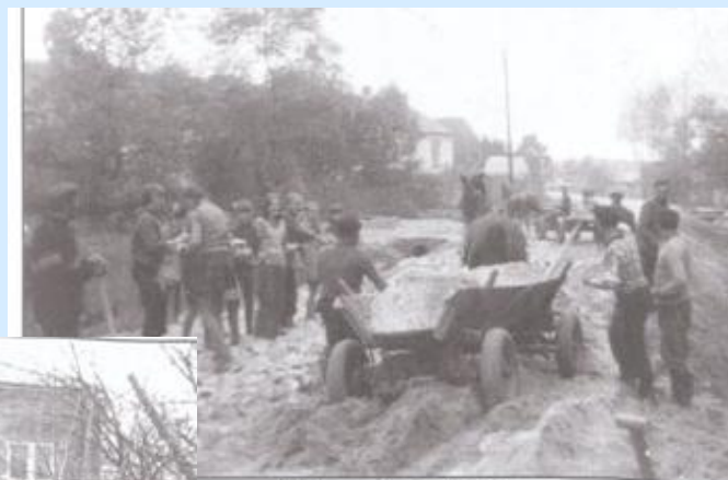
Budowa drogi, rok 1974
